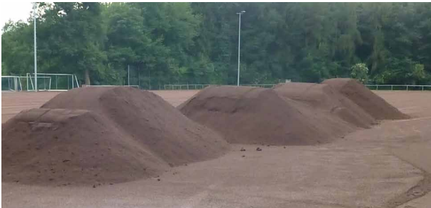
Abtrag der alten Tennenschicht
